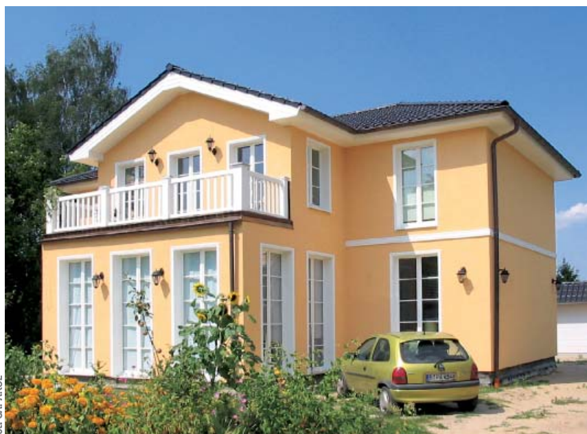
▲ Taras nad pomieszczeniem ogrzewanym
