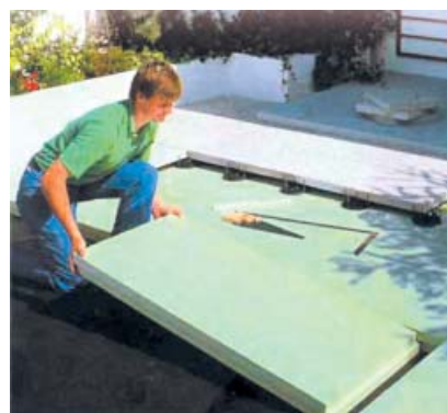
▲ Warstwę ocieplenia wykonuje się z płyt polistyrenu ekstrudowanego
