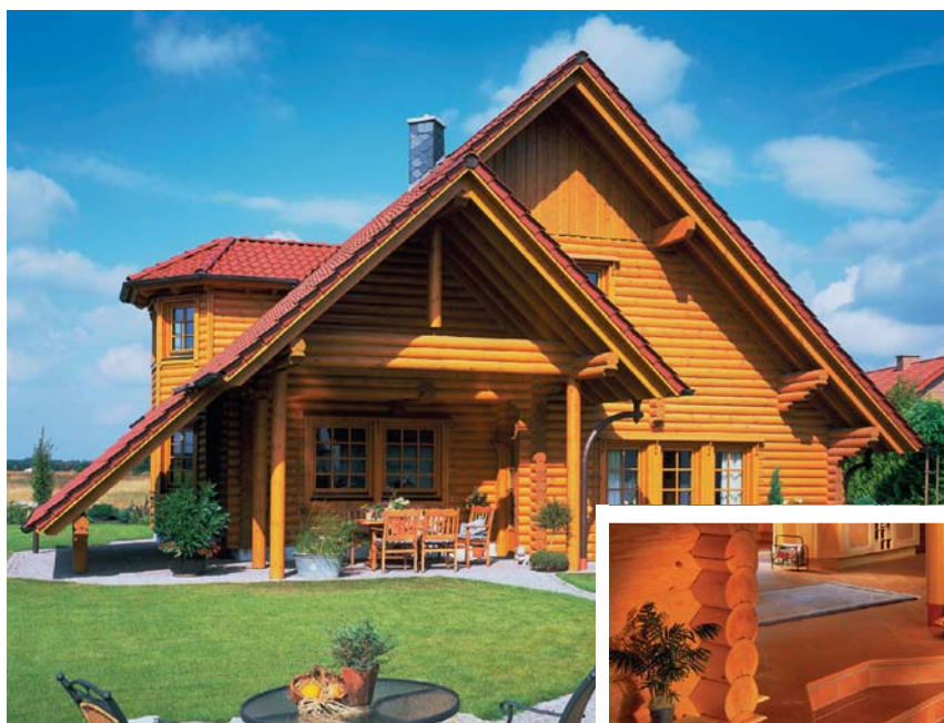
12 Dom z bali także wewnątrz ukazuje swoją konstrukcję (fot. Findrewno) ▲
