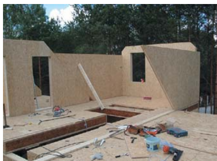
11 Tempo prac przy domu szkieletowym również jest duże (fot. Unibud) ▲
