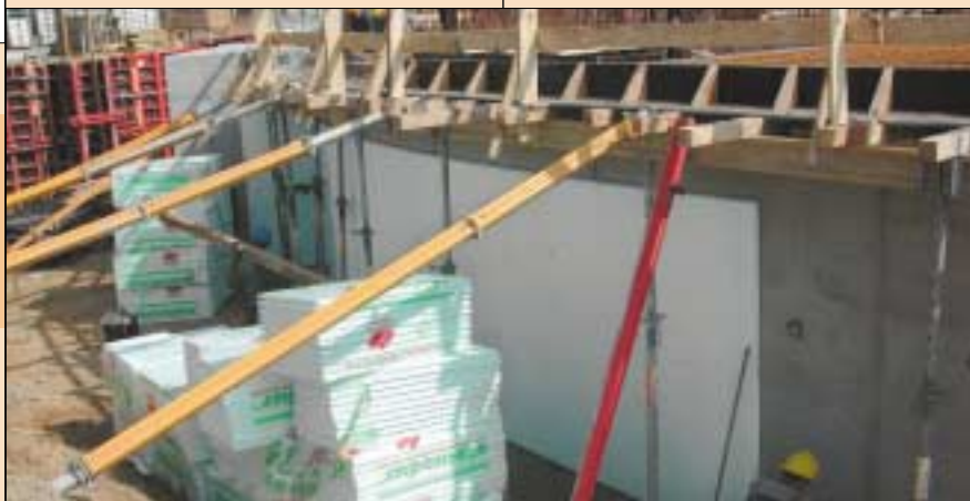
6 Termoizolacja fundamentów (fot. Izoterm)
