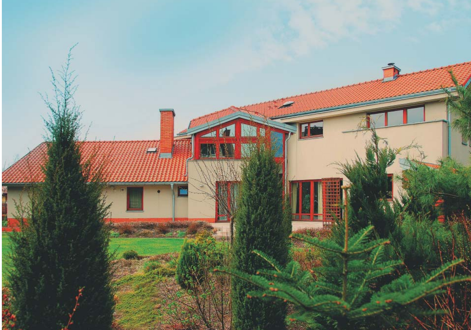
Ogród od południowego wschodu. Dwa rozwarte skrzydła domu całkowicie osłaniają go przed wzrokiem ciekawskich, a do tego stanowią zapórę dla odgłosów najbliższej ulicy i dla silnych zachodnich wiatrów
