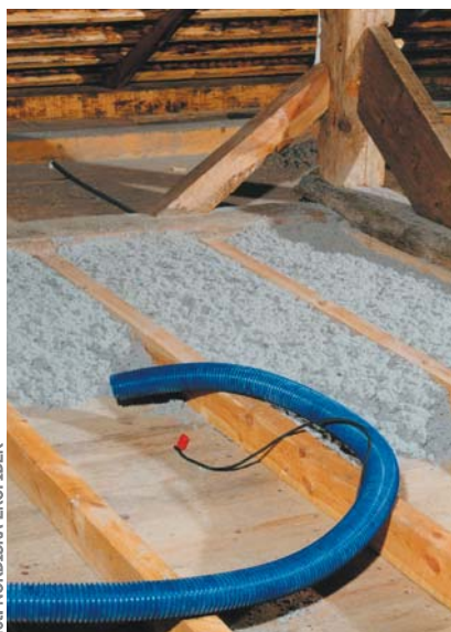
▲ Metoda wdmuchiwania materiału izolacyjnego pozwala ocieplić trudno dostępne miejsca
